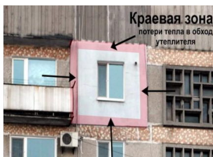
Рисунок 2. Утепление фасада панельного дома фрагментами
